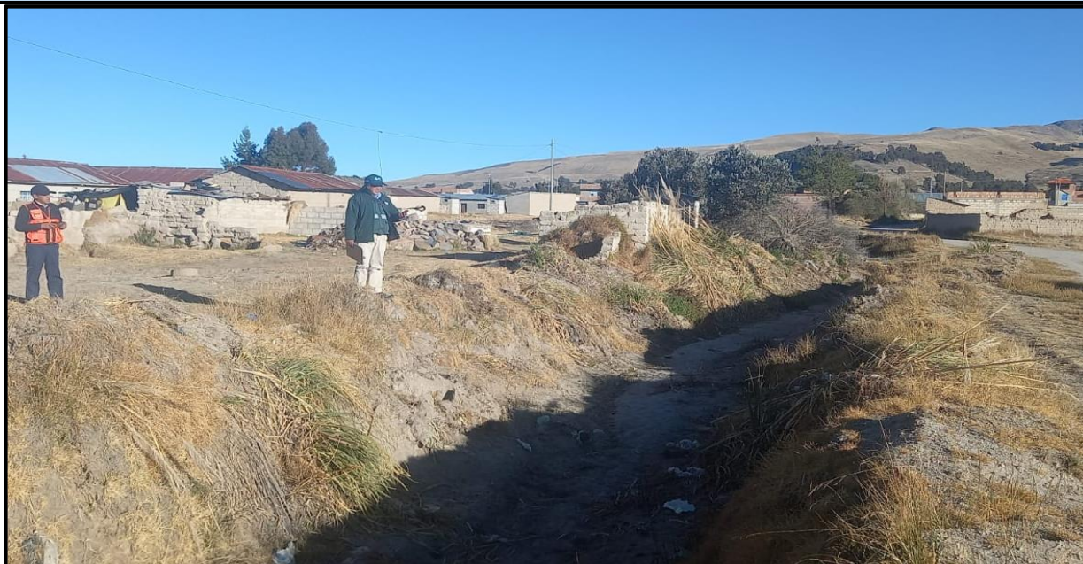
FOTO N°01: En la fotografía se observa un tramo de quebrada con un cauce reducido, en proceso de colmatación por sedimentos finos en sus márgenes. La quebrada muestra obstrucciones y acumulación de desechos que limitan la conducción natural del agua. La infraestructura cercana (viviendas y muros de adobe/piedra) se encuentra muy próxima al cauce, lo que incrementa la vulnerabilidad ante crecidas.
