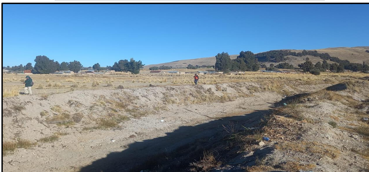
FOTO N°02: En la imagen se aprecia un cauce amplio de quebrada con evidente proceso de colmatación por sedimentos arenosos y limo-arcillosos, lo que ha reducido su sección hidráulica efectiva. El lecho presenta acumulación de material seco y dispersión de residuos sólidos, lo cual compromete la capacidad de conducción frente a futuras avenidas pluviales.
